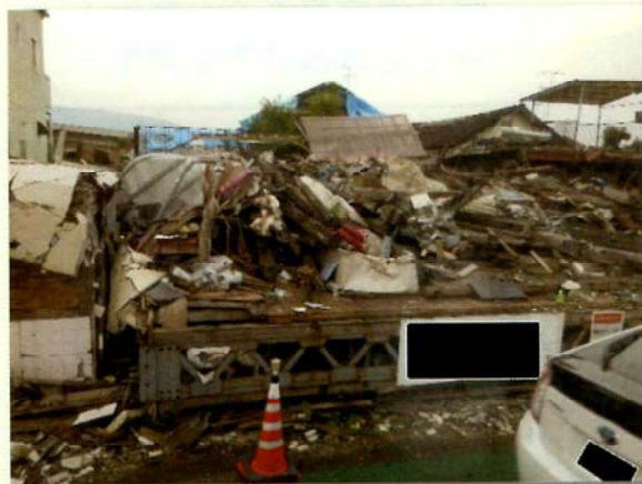
益城町被災状況
