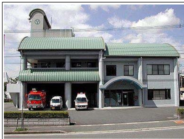
▲筑紫野消防署南出張所庁舎
