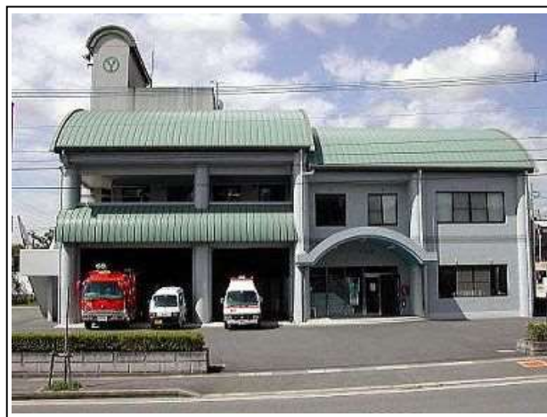
▲筑紫野消防署南出張所庁舎
