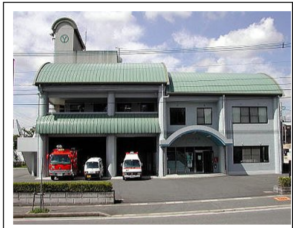
▲筑紫野消防署南出張所庁舎
