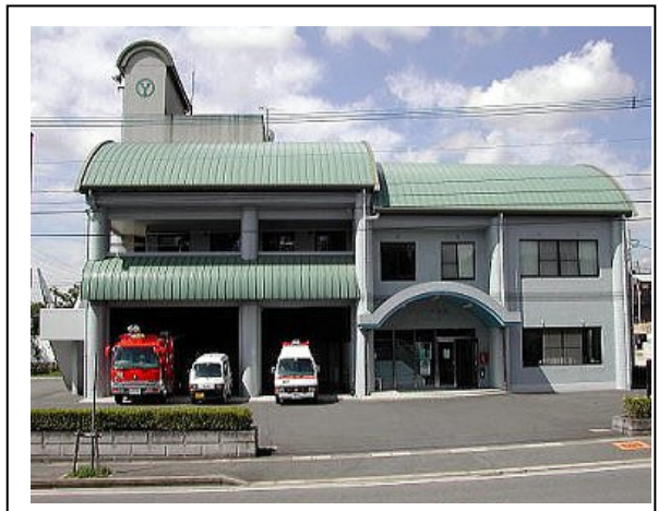
▲筑紫野消防署南出張所庁舎
