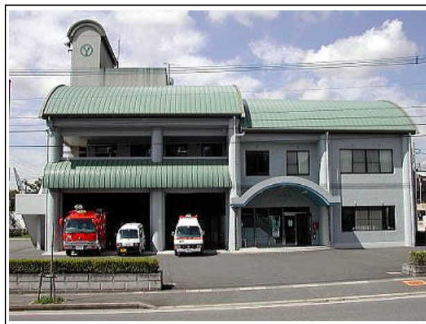
▲筑紫野消防署南出張所庁舎
