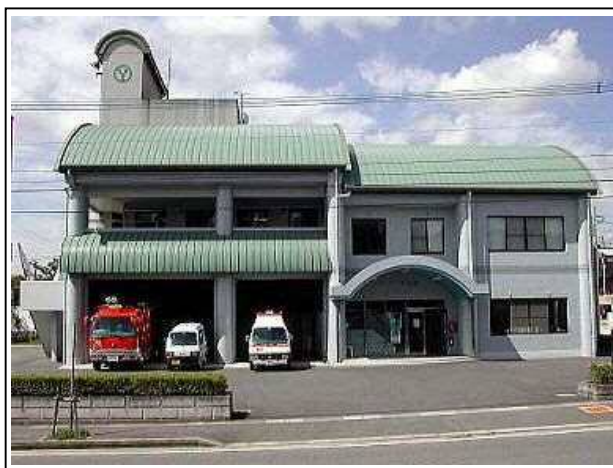
▲筑紫野消防署南出張所庁舎
