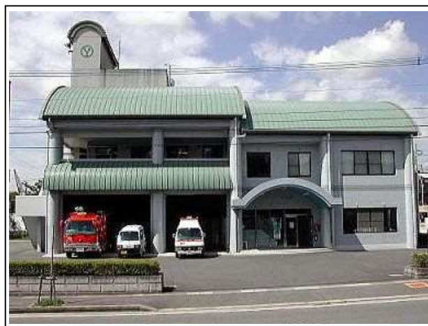
▲筑紫野消防署南出張所庁舎
