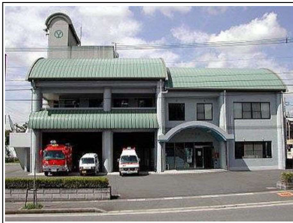
▲筑紫野消防署南出張所庁舎
