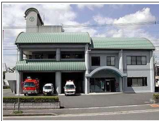
▲筑紫野消防署南出張所庁舎
